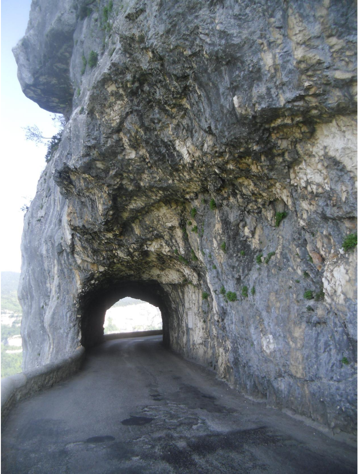
Combe Laval, un des tunnels (10 juillet 2015)
